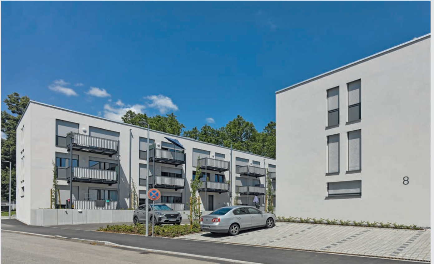
Wohnanlage | Großgartacher Straße, Heilbronn-Böckingen
